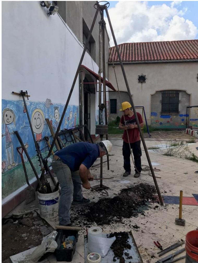
Fig. 3 Ensayo SPT (Ensayo normalizado de penetración)
